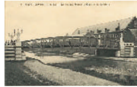
Ancien pont de la gare.
